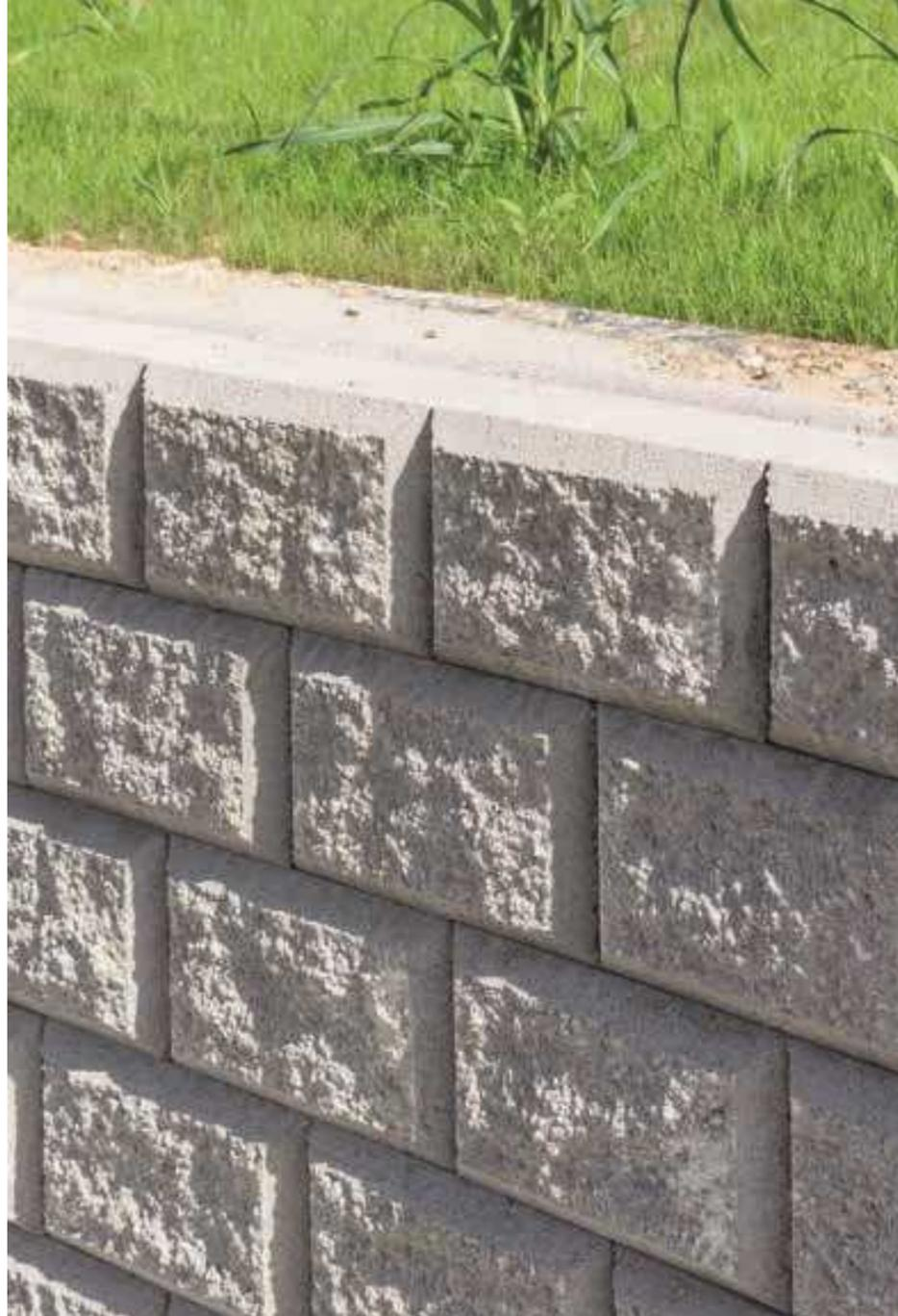
MURO A SECCO INCLINATO DI 8°
